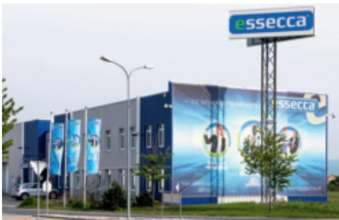
Essecca-Zentrale in Bad Fischau: Fokussiert auf Gesamtlösungen
